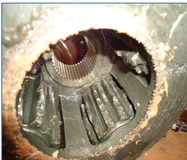
INTERNOS DA CAIXA SATÉLITE DANIFICADA
